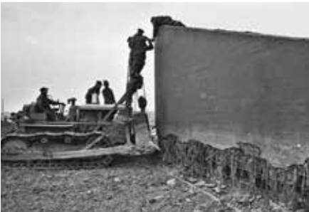
Afbraak van de stuw bij Olst in 1965. Bron: Memory of the Netherlands
